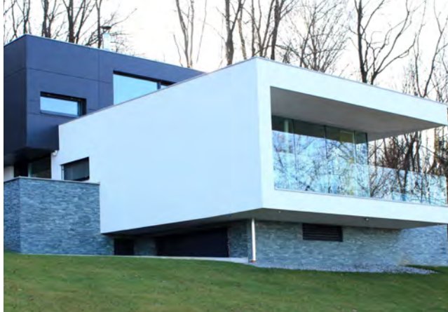
Das Haus in Hanglage vereint Architektur und Technik
